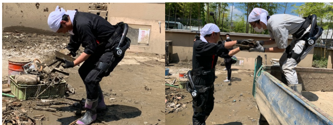
2020年7月30日 (人吉市内での復旧作業)
