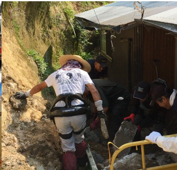
2020年8月21日 (瓦礫撤去作業)
