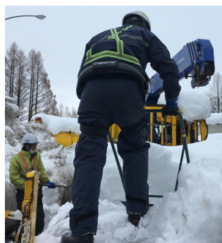
雪下ろし作業 (2)
